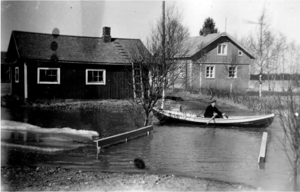
Tavanomainen kevättulva. Kuvassa vasemmalla näkyvä rakennus on aikoja sitten purettu. Se oli Järvenpään Viljalan 1. asuintalo. Sitten se toimi saunana, kanalana ja verstaana.
