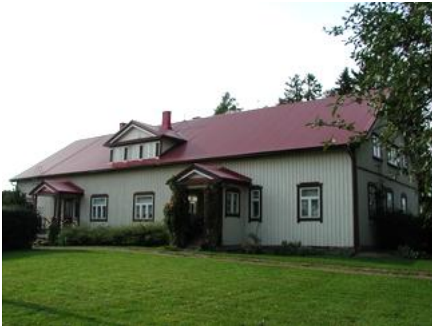
Turton asuinrakennuksena on entinen väentupa, jota levennettiin ja korotettiin 1938
