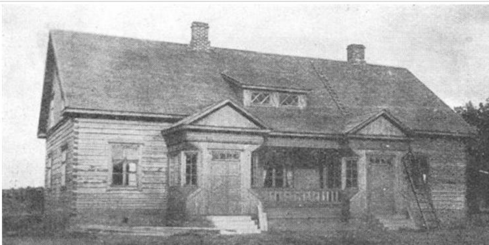
Isohonkon päätalo 1932. Rakennus on vuodelta 1878, uusittu 1927
